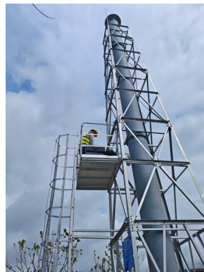
1#生物滤池排气筒废气采样口 (DA001)
